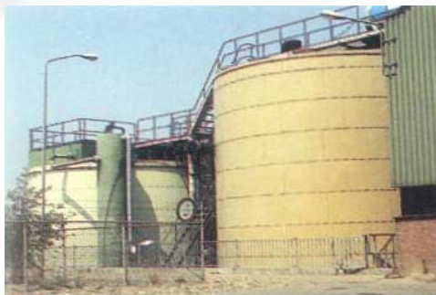
Εικόνα 21: Τυπικά συστήματα αναερόβιας χώνευσης [53]
