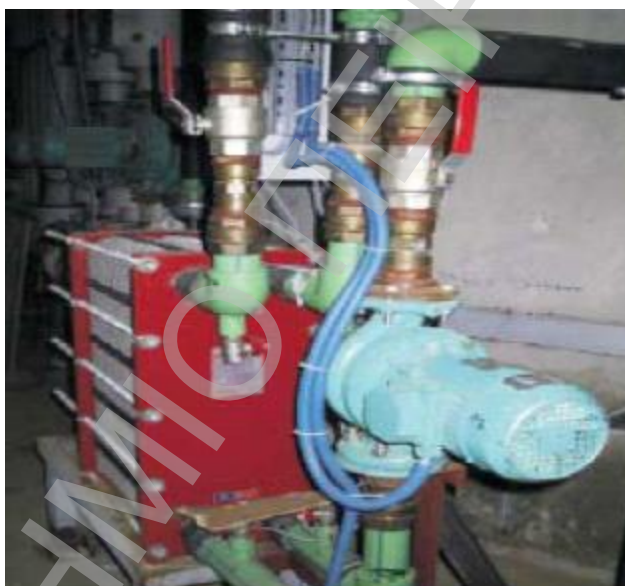
Εικόνα 4.3 Ένας πλακοειδής εναλλάκτης θερμότητας και μία αντλία του κεντρικού συστήματος σε ένα από τα ξενοδοχεία του Ομίλου Aldemar στην Κρήτη. Ο εναλλάκτης χωρίζει το πρωτεύων κύκλωμα των ηλιακών συλλεκτών από το δευτερεύον κύκλωμα της κατανάλωσης, Πηγή ΚΑΠΕ
