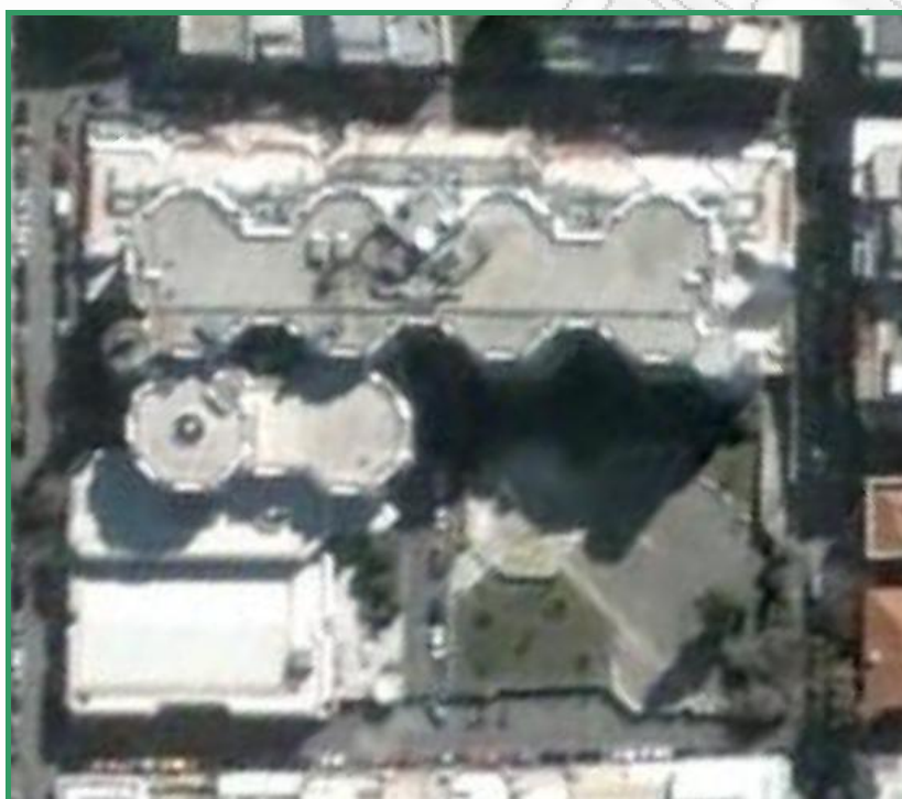
Εικόνα 6-4 Οροφή Κεντρικού Κτιρίου Πανεπιστημίου Πειραιώς.
