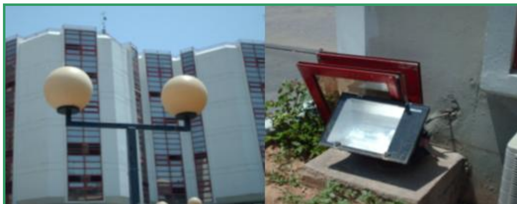
Εικόνα 3-10 Φωτισμός Περιβάλλοντος Χώρου Κεντρικού Κτιρίου Πα.Πει.
