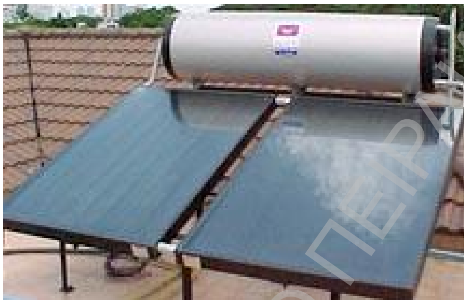
Σχήμα 2.4: Ηλιακό θερμοσιφωνικό σύστημα για θέρμανση νερού
