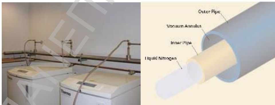
Διάγραμμα V-2. Απεικόνιση Δικτύου και Εσωτερικής Δομής Σωληνώσεων
