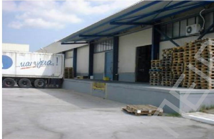
Φωτογραφία 2: Ράμπα Φόρτωσης ετοιμών προϊόντων για Αποστολή
