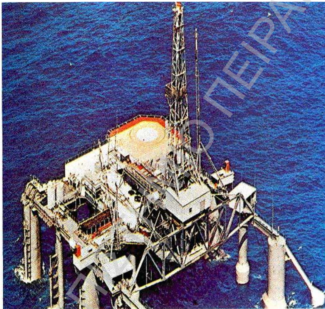
Σχήμα 5.4. Εγκατάσταση υποθαλάσσιας γεώτρησης: [4]
