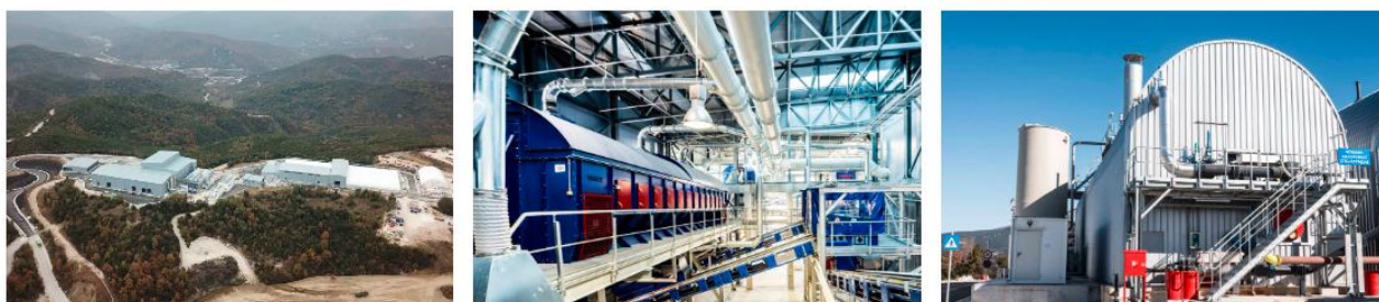
Εικόνα 10: Η μονάδα στην Ήπειρο Πηγή (ΤΕΡΝΑΕΝΕΡΓΕΙΑΚΗ, 2020)
