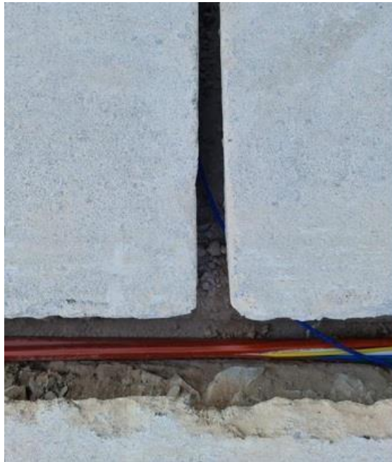
Εικόνα 3.12: Micro-Trenching (κάθετης ένθετης οπτικής καλωδίωσης)
