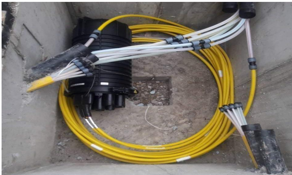
Εικόνα 3.14: Εσωτερική όψη φρεατίου
