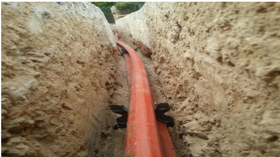
Εικόνα 3.11: Mini-Trenching (μικροτάφρος)
