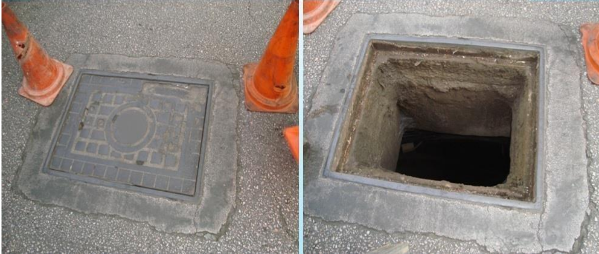
Εικόνα 3.13: Εξωτερική όψη φρεατίου
