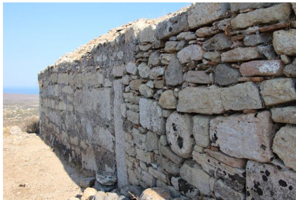
Εικόνες 46-48. Οικοδόμηση κτιρίων με συμπληρώσεις αρχαίου οικοδομικού υλικού
