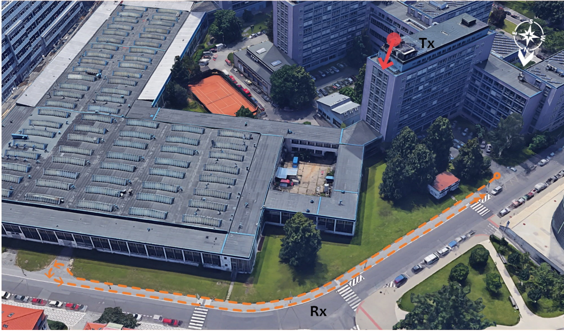
Σχήμα 3.8: Περιβάλλον μέτρησης Σεναρίων Δρόμου-Οροφής P1 & P2. Το κόκκινο βέλος δείχνει τη θέση και την κατεύθυνση εκπομπής του Tx πάνω στο κτίριο, ενώ ο δέκτης ακολουθεί την προδιαγεγραμμένη πορεία (πορτοκαλί διακεκομμένη γραμμή)
