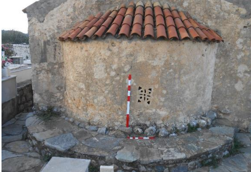
Εικόνα 27: Η αψίδα του ιερού έχει κτιστεί στην εσωτερική παρειά της αψίδας του ιερού παλαιότερου ναού.
