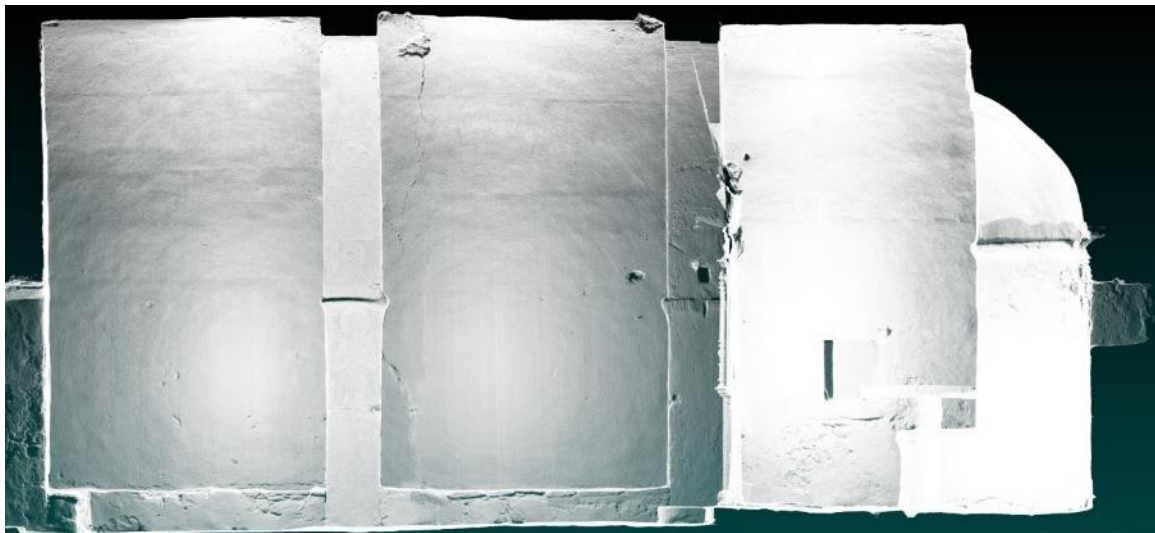
Εικόνα 52: Πάνω (α) εικονίζεται φωτογραφία της εσωτερικής παρειάς της τοιχοποιίας του βόρειου τοίχου του ναού σε ορθή προβολή και κάτω (β) ορθοφωτογραφία της βορείας εσωτερικής όψης χωρίς χρώματα, παρά μόνο με τις ανάγλυφες αλλοιώσεις της επιφάνειας της τοιχοποιίας
