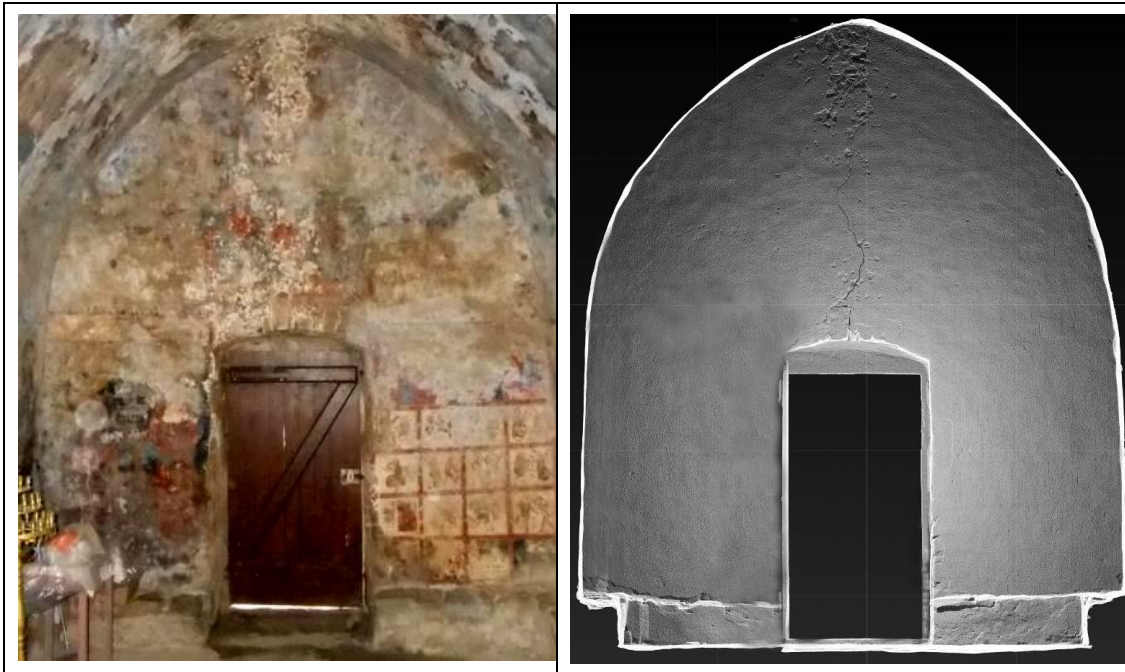
Εικόνα 50: Εσωτερική παρειά δυτικής τοιχοποιίας. Αριστερά εικονίζεται φωτογραφία δυτικού τοίχου του ναού και δεξιά ορθοφωτογραφία της δυτικής εσωτερικής όψης χωρίς χρώματα, παρά μόνο με τις ανάγλυφες αλλοιώσεις της επιφάνειας της τοιχοποιίας
