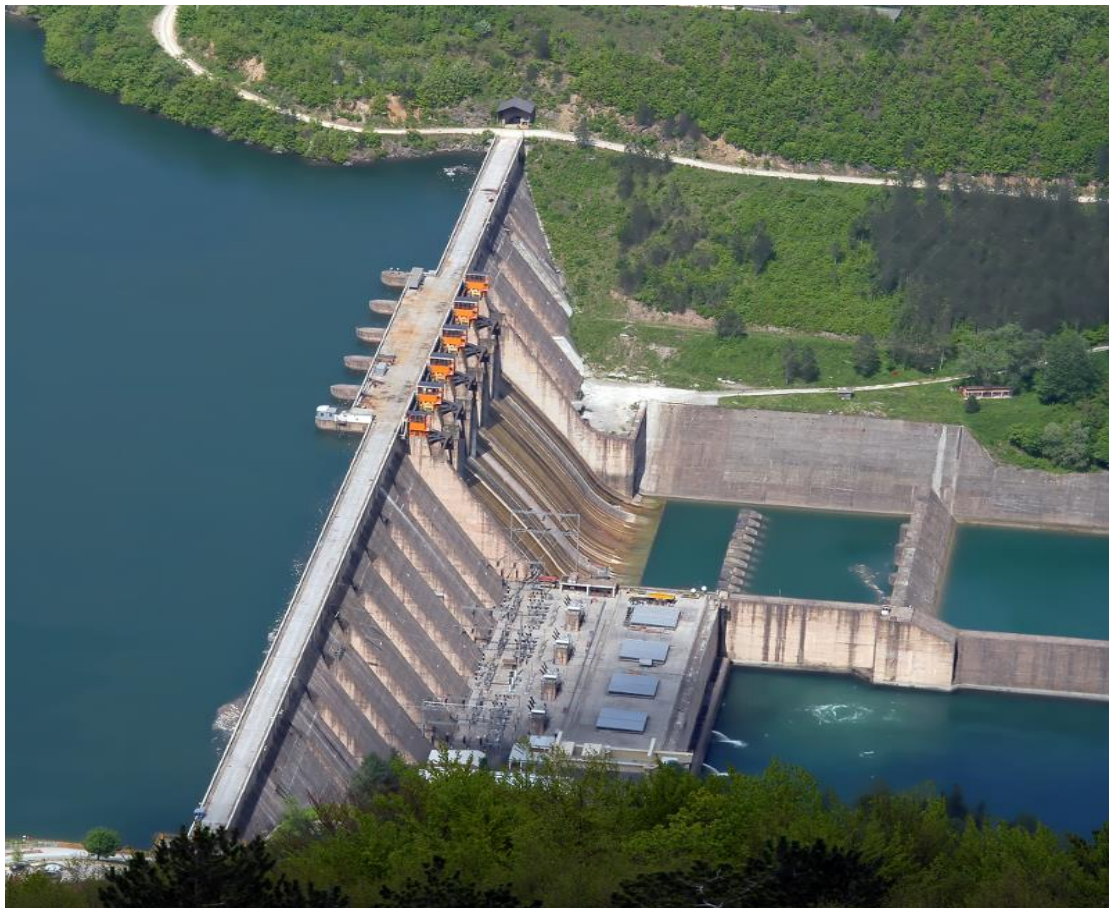
Εικόνα 2: Σύγχρονη υδροηλεκτρική μονάδα
