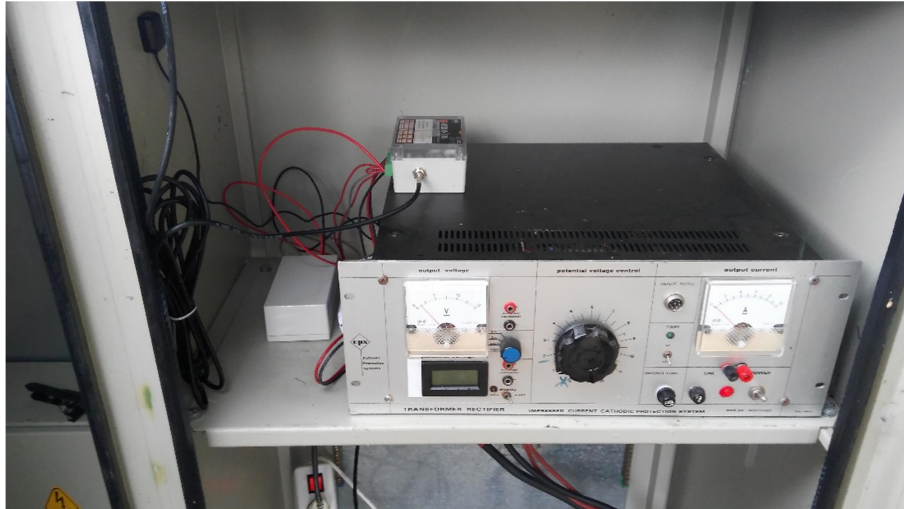
Σχήμα 9: Εγκατάσταση συσκευής τηλεμέτρησης σε τροφοδοτικό ΚΠ
