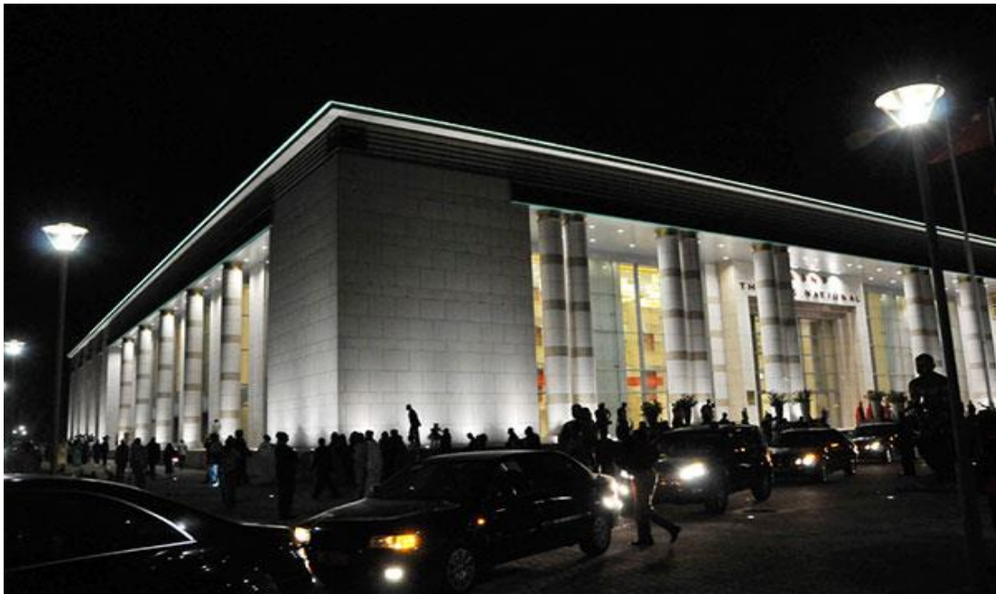
Εικόνα 6. Το θέατρο Dakar National Grand Theater στη Σενεγάλη, κατασκευάστηκε από κρατική κινεζική εταιρεία και το μεγαλύτερο ποσοστό χρηματοδότησης επήλθε από κινεζικά κεφάλαια, Πηγή: http://english.gov.cn/news/photos/2015/12/02/content_281475246524074.htm
