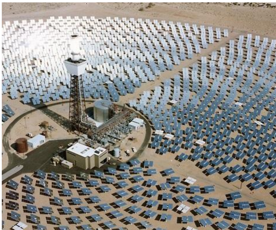
Εικόνα 2. 1 Σταθμός παραγωγής ενέργειας του τύπου CSP. Πηγή: Ζαχαρίας Θ.(2005)Ηπιες Μορφές Ενέργειας II, Πάτρα
