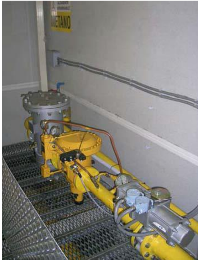
Εικόνα 36 Τυπική διάταξη GUV room της Wärtsilä
