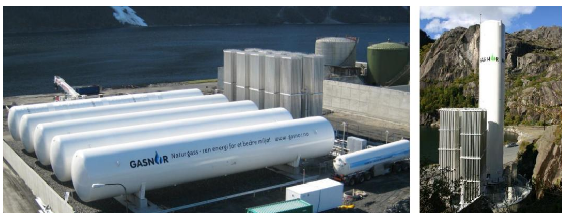
Εικόνα 1.5: Τερματικός σταθμός Møsjoen στην Νορβηγία με δεξαμενές χωρητικότητας 5.000m 3 (αριστερά) και ο σταθμός Titania στην Νορβηγία με δεξαμενές 250m 3 (δεξιά) (πηγή : Gasnor AS (Shell))
