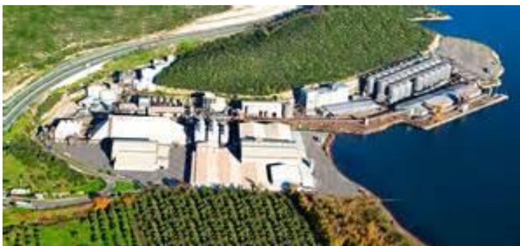
2.2.a. Πανοραμική άποψη του εργοστασίου της Agroinvest ΑΕΒΕ, στην τοποθεσία Αχλάδι στη Φθιώτιδα.
