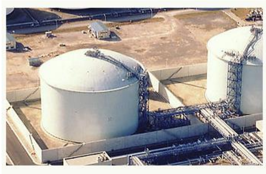
Εικόνα 18: Υπέργεια Δεξαμενή κάθετης διατομής αποθήκευσης LPG
