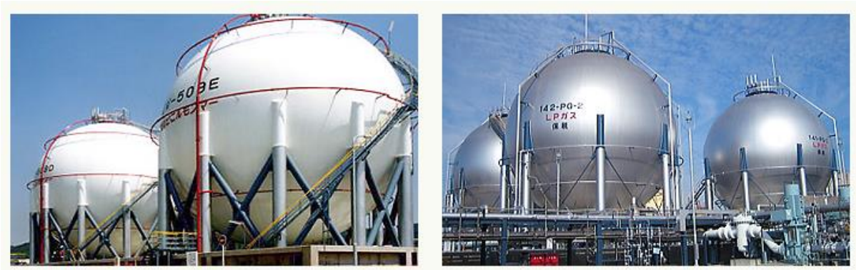
Εικόνα 17: Σφαιρικές υπέργειες δεξαμενές
