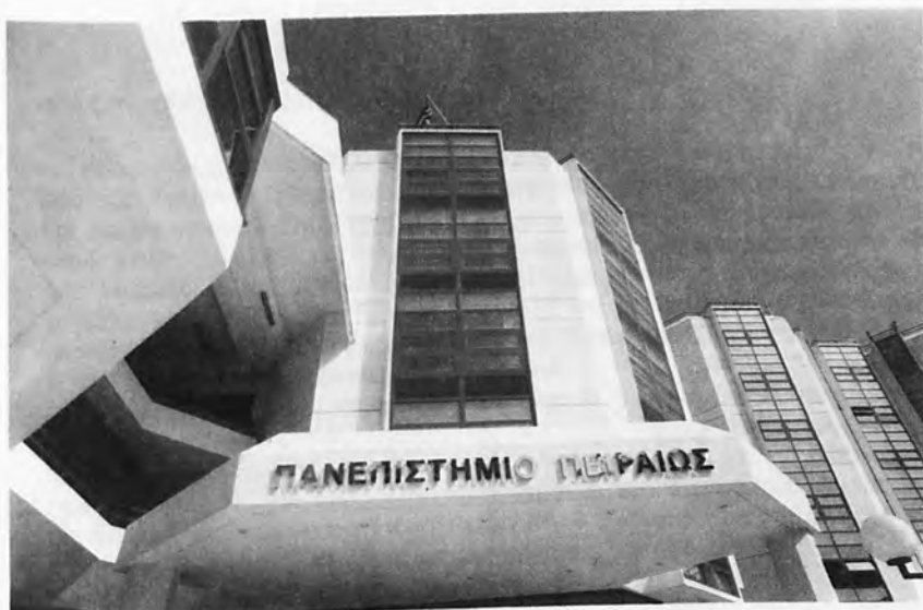
Το κτιριακό συγκρότημα του Πανεπιστημίου συνολικής επιφάνειας 23.700 τ.μ. που εγκαινιάστηκε στις 28 Απριλίου 1993.
