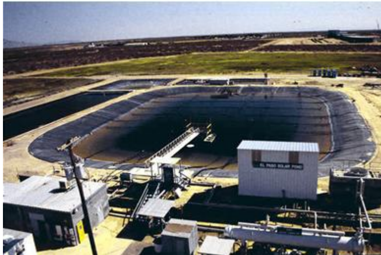
Εικόνα X: Εφαρμογή ηλιακής λίμνης στο Ελ Πάσο του Τέξας
