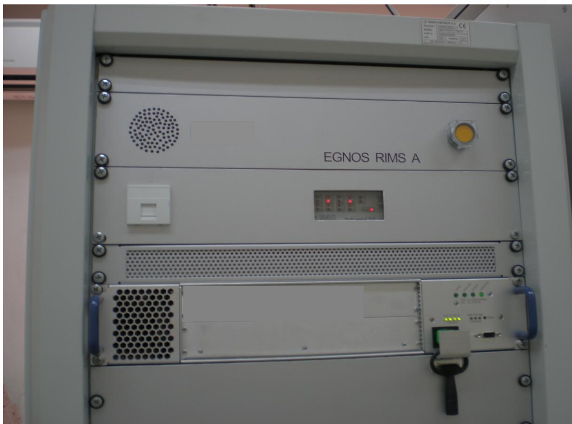
Στο κρύωμα του καναλιού RIMS A φαίνεται το switch του τοπικού LAN, η RJ45 πρίζα του Η/Υ τοπικής συντήρησης και ο κυρίως Η/Υ του καναλιού RIMS A
