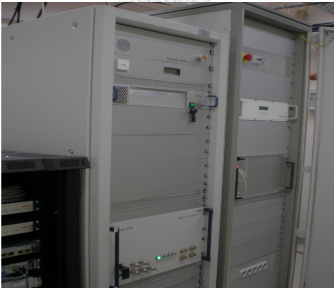
Σύστημα εισόδου, συγχρονισμού και τροφοδοσίας της δορυφορικής GPS κεραίας του καναλιού RIMS_A και διασύνδεση όλου του ικριώματος (Rack) με το τοπικό δίκτυο Ethernet του σταθμού.
