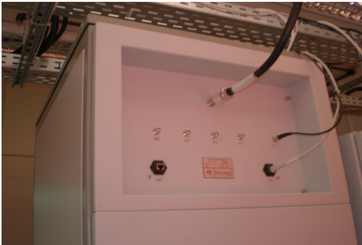
Σύστημα εισόδου, συγχρονισμού και τροφοδοσίας της δορυφορικής GPS κεραίας του καναλιού RIMS_A και διασύνδεση όλου του ικριώματος (Rack) με το τοπικό δίκτυο Ethernet του σταθμού.
