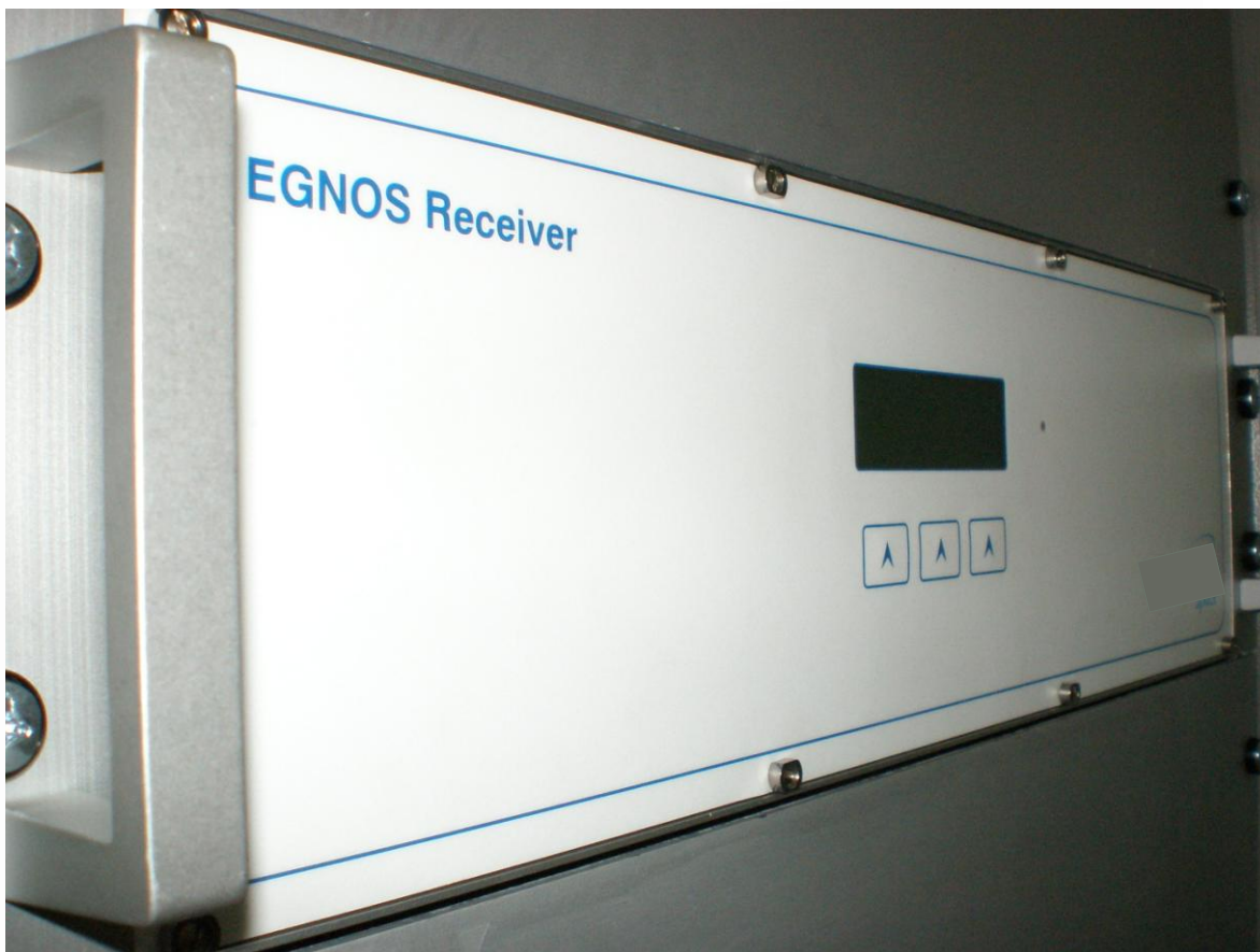
Ο Δορυφορικός δέκτης GPS τοποθετημένος στο κριώμα του RIMS B
