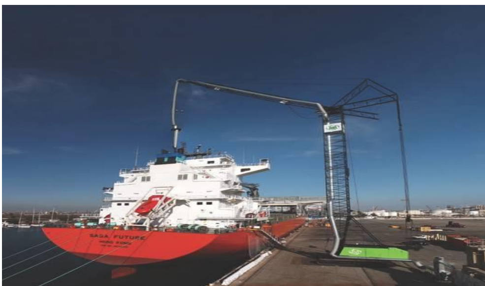
Εικόνα: Σύστημα επεξεργασίας εκπομπών αποβάθρας
