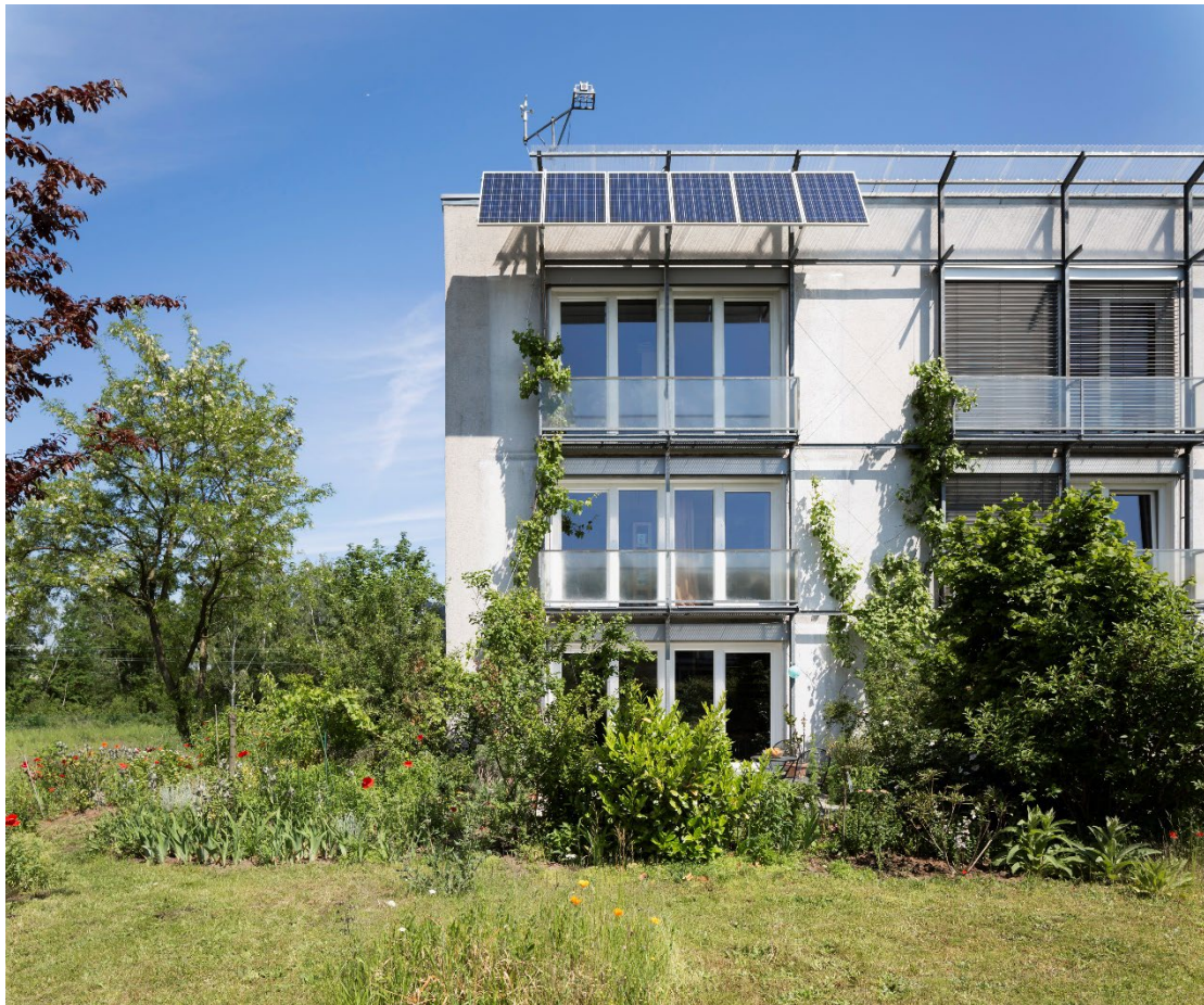
Εικόνα 25 Passivhaus Darmstadt Kranichstein
