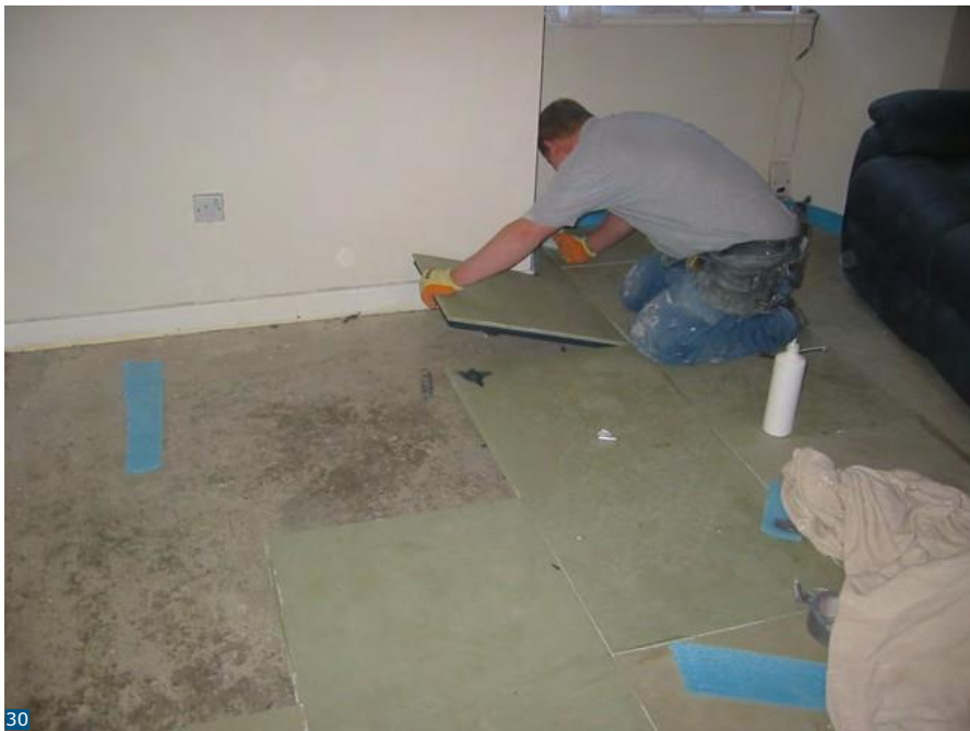
Εικόνα 30: Τοποθετείται σανίδα Airgel σε τσιμεντένιο πάτωμα. Εικόνα © Changeworks
