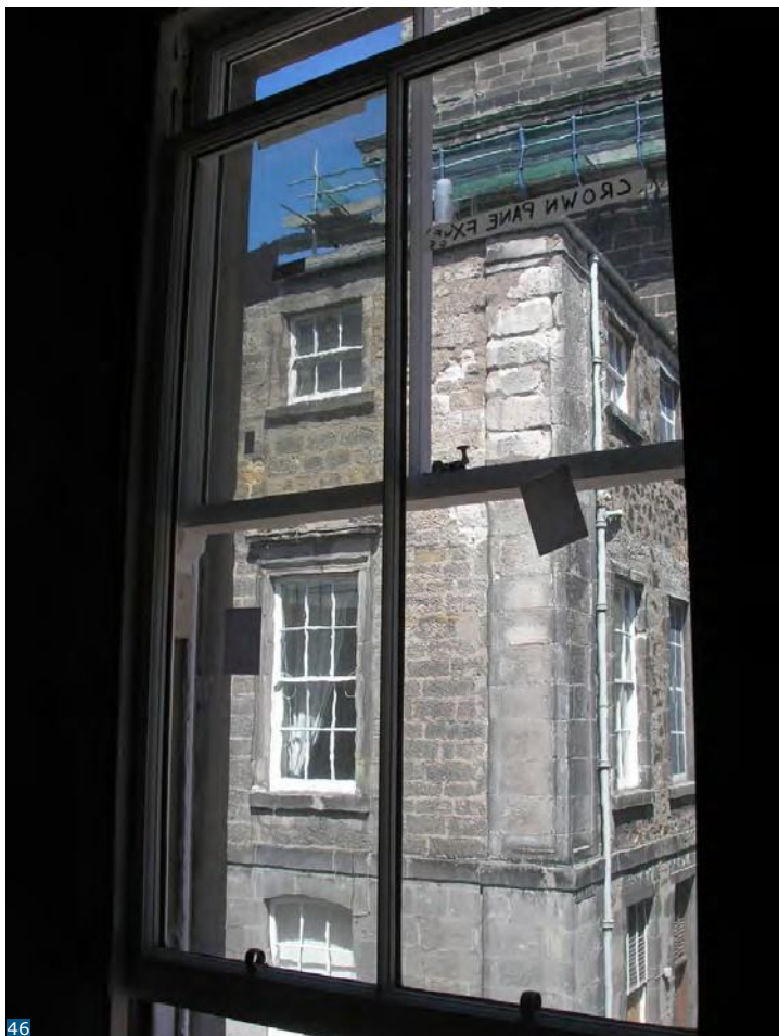
Εικόνα 46: Γνήσιο γυαλί τροποποιημένο ώστε να σχηματίζει μια μονάδα στενού προφίλ με διπλά τζάμια.
