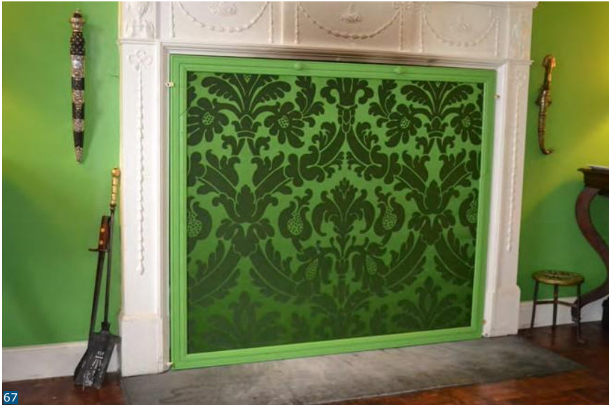
Εικόνα 67: Μια σανίδα εστίας που χρησιμοποιείται για να κλείσει προσωρινά ένα τζάκι.
