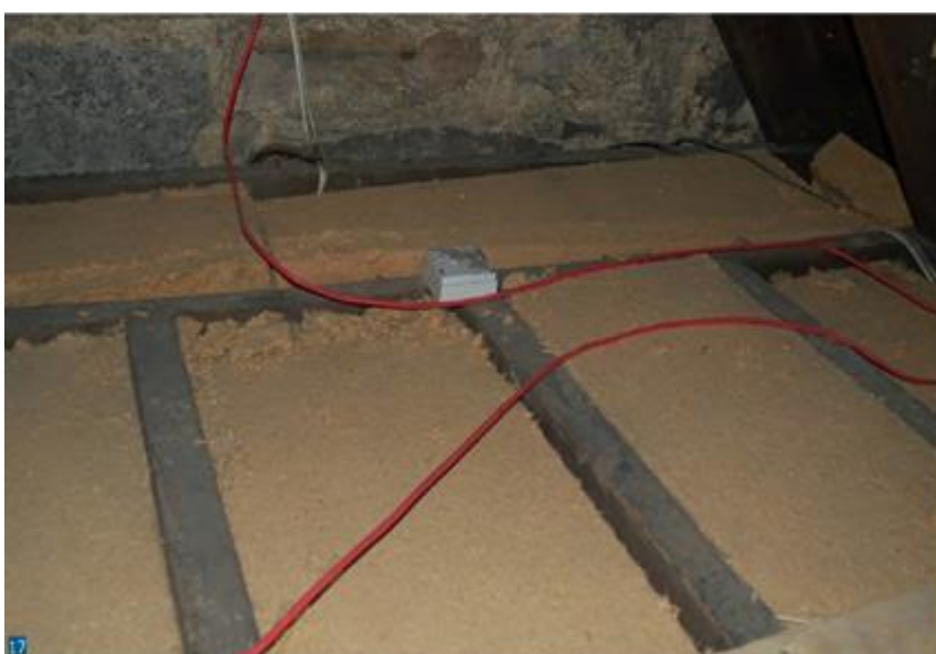
Εικόνα 16: Μόνωση από μαλλί προβάτουστρωμένο ανάμεσα σε δοκούς στο Κάστρο του Εδιμβούργου.
