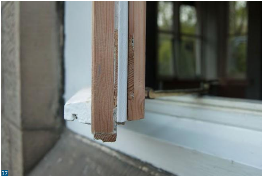
Εικόνα 37: Μια πρόσφατα τοποθετημένη λωρίδα βούρτσας (λευκή) σε ένα παράθυρο στο HolyroodParkLodge.
