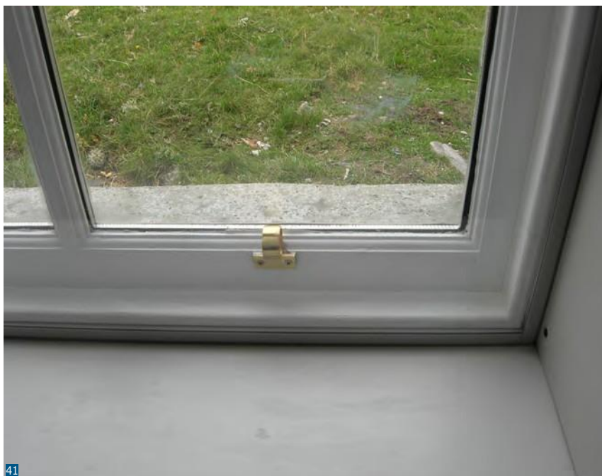
Εικόνα 41: Πολυκαρβονικό δευτερεύον τζάμι τοποθετημένο σε μαγνητική ταινία.
