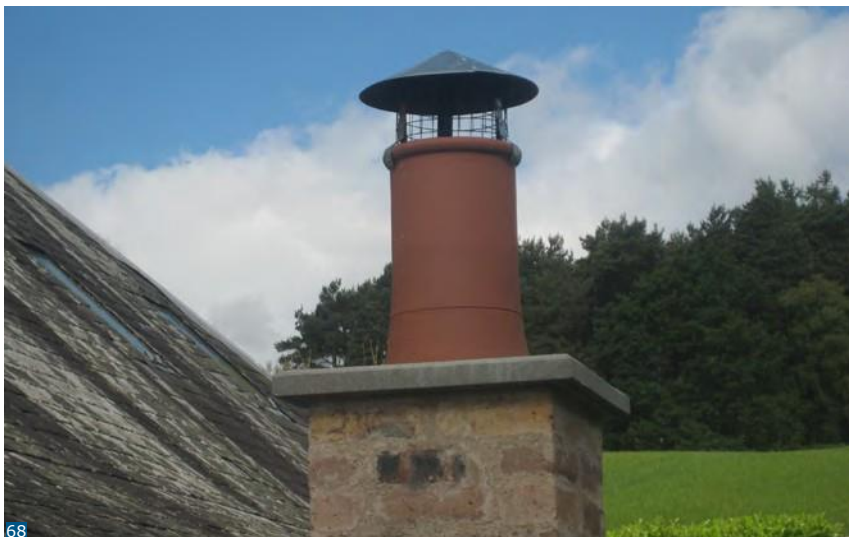
Εικόνα 68: Μια κουκούλα με πλέγμα διατηρεί την καμινάδα στεγνή, αλλά αεριζόμενη και απαλλαγμένη από πουλιά.
