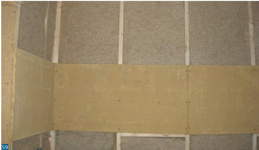
Εικόνα 59: Μόνωση από ίνες κάνναβης με πηλίνη σανίδα.
