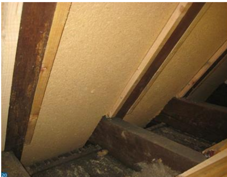
Εικόνα 20: Μια κλίση στέγης μονωμένη με μόνωση από ξύλινη ινοσανίδα μεταξύ των δοκών.
