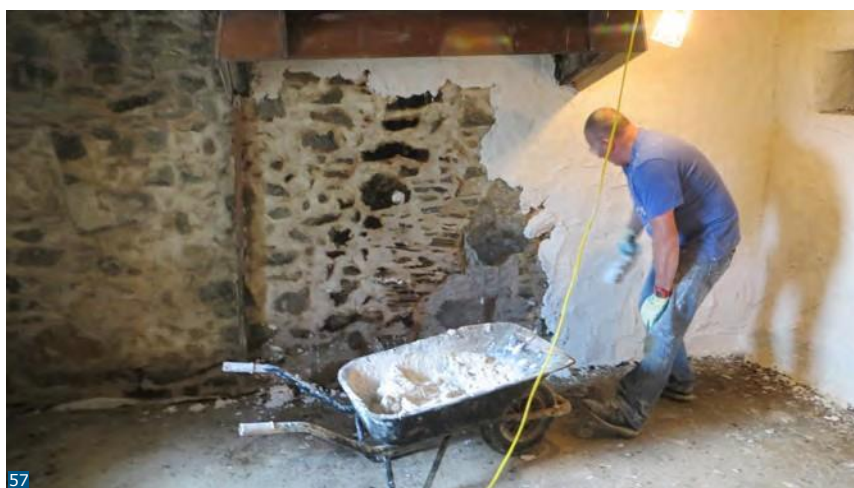
Εικόνα 57: Πρώτη στρώση μονωμένου ασβεστοκονιάματος που εφαρμόζεται απευθείας στην τοιχοποιία της Κατηγορίας Το Downie's Cottage που είναι καταχωρημένο σε λίστα, κοντά στο Braemar. Μια δεύτερη στρώση εφαρμόζεται με τον ίδιο σχεδόν τρόπο.
