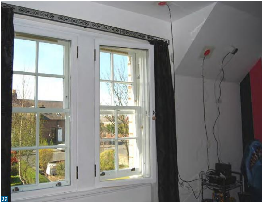
Εικόνα 39: Δευτερεύον τζάμι με ξύλινο πλαίσιο σε παράθυρο θυρίδας.
