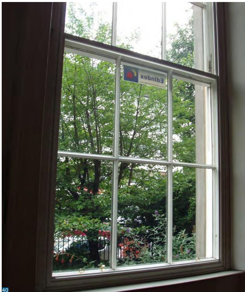
Εικόνα 40: Δευτερεύον τζάμι τοποθετημένο μέσα στις χάντρες του προσωπικού, επιτρέποντας τη χρήση παντζουριών.
