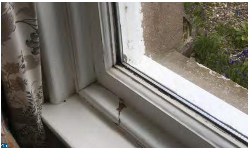
Εικόνα 45: Μονάδα διπλού υαλοπίνακα τυπικής διάστασης τοποθετημένη σε υπάρχον φύλλο.
