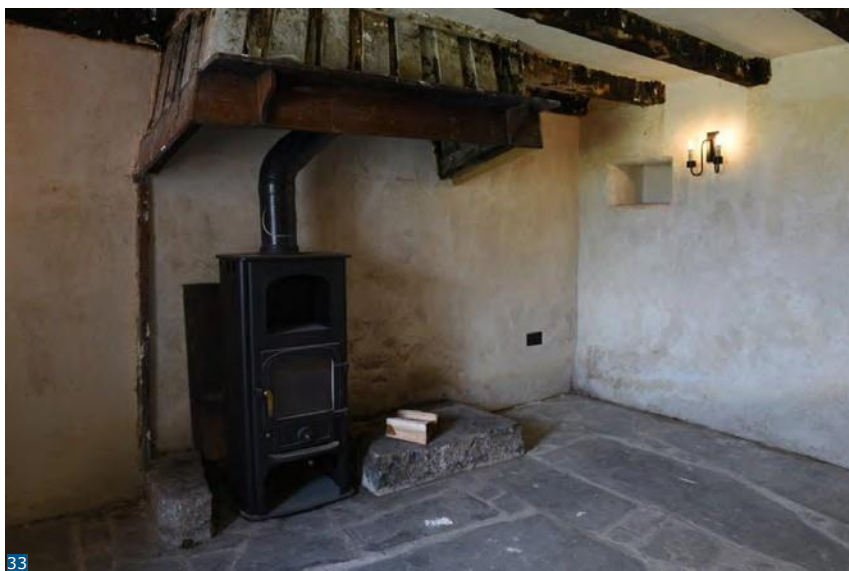
επανατοποθετείται σε ασβεστομπετόν θερμαινόμενοπλάκα.
