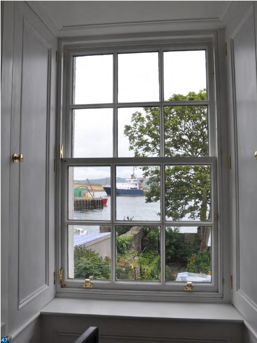
Εικόνα 47: Ένα νέο παράθυρο φύλλου και θήκης σε παράθυρο της κατηγορίας B στο Stromness. Σημειώστε τα νέα λειτουργικά ρολά.
