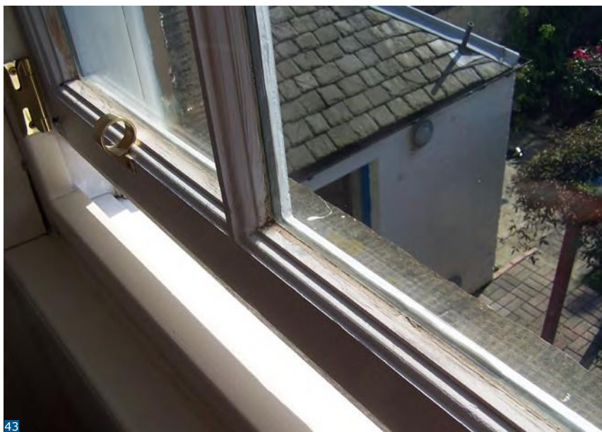
Εικόνα 43: Τα στενά προφίλ με διπλά τζάμια τοποθετούνται σε ένα υπάρχον φύλλο παραθύρου. Εικόνα © GordonBarclay
