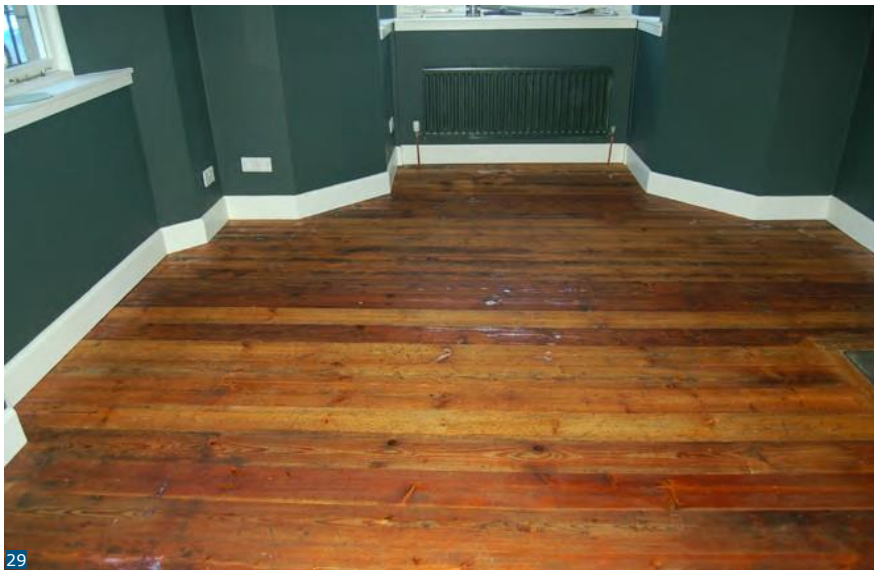
Εικόνα 29: επανατοποθετημένο δάπεδο.
