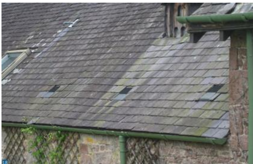
Εικόνα 18: Αεραγωγοί οροφής χαμηλού προφίλ σε οροφή από σχιστόλιθο μετά από αναβάθμιση στον χώρο της οροφής.
