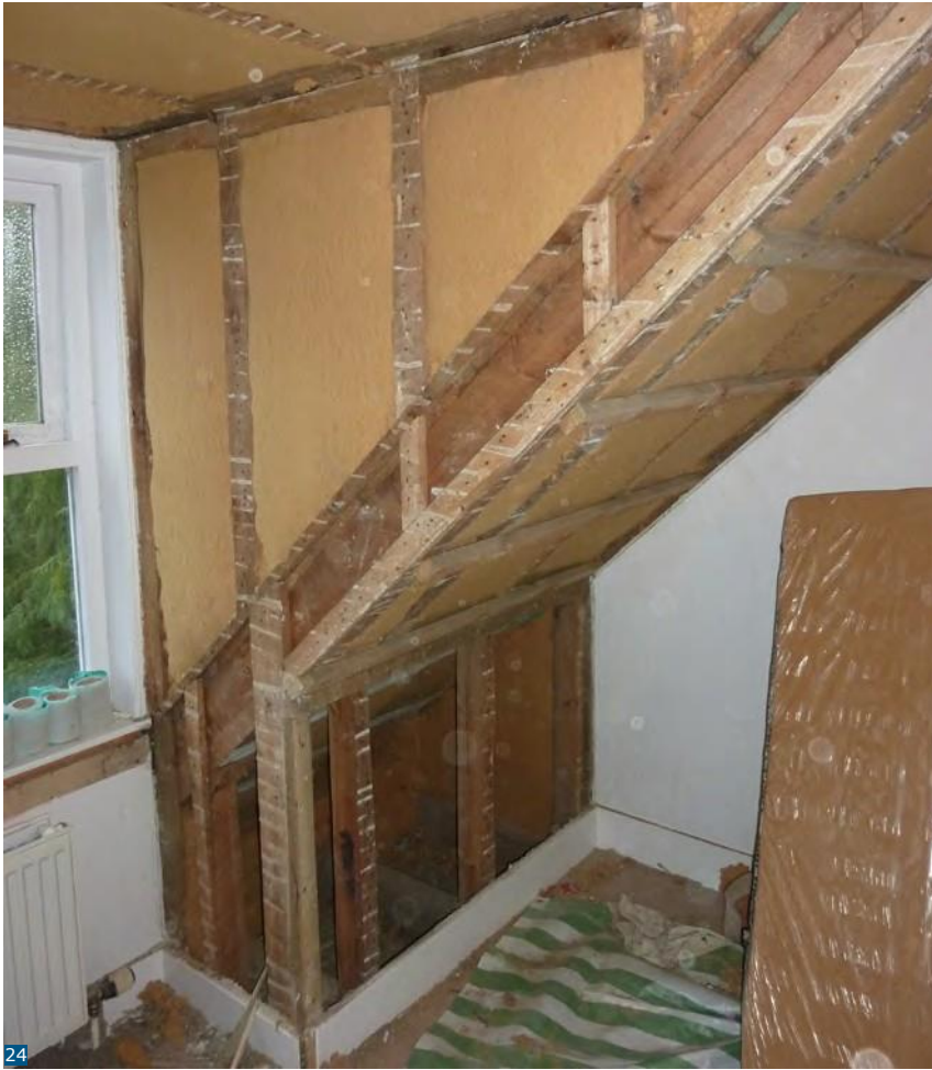
Εικόνα 24: Εργασίες μόνωσης σε κοιτώνα με χρήση ξύλινων ινοσανίδων.
