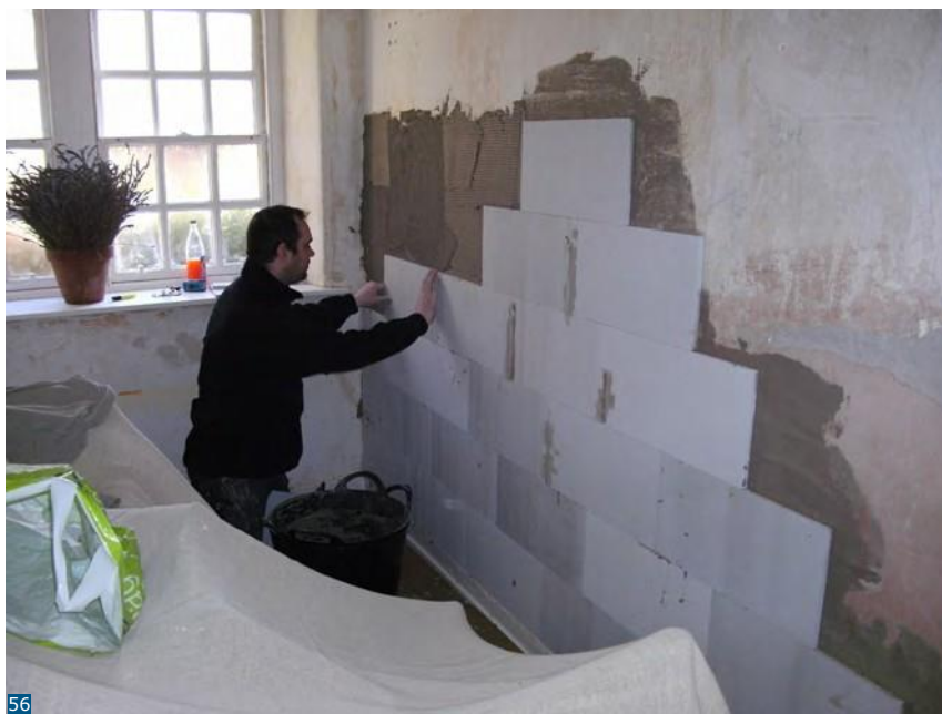
Εικόνα 56: Εφαρμογή των μονωτικών πλακών πυριτικού ασβεστίου.
