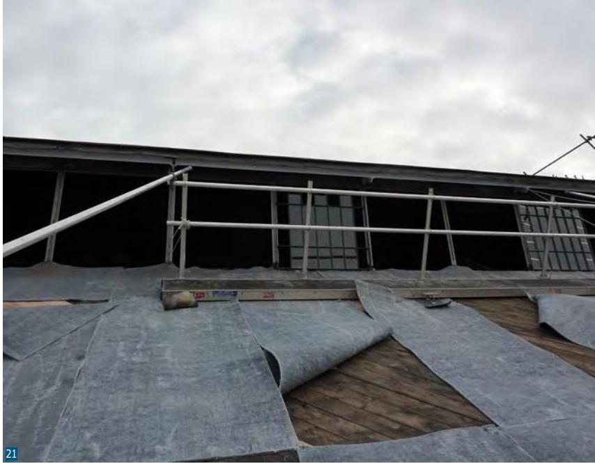
Εικόνα 21: Μια μονωτική κουβέρτα αερογέλης τοποθετημένη πάνω από το sarking.
