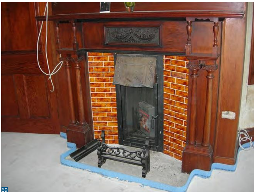
Εικόνα 69: Ένα υπάρχον ένθετο από χυτοσίδηρο Εδουαρδιού, εξοπλισμένο εκ των υστέρων με γυάλινη σχάρα για πιο αποτελεσματική καύση.
