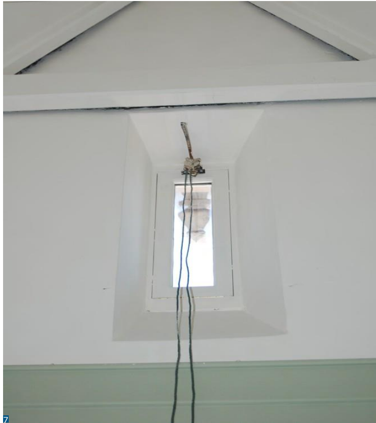
Εικόνα 7: Αυτό το τέταρτο παράθυρο έχει γίνει για τον διαχειριζόμενο αερισμό
