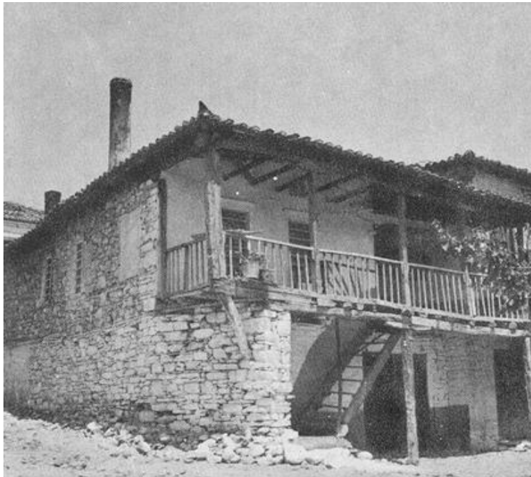
Εικόνα 3.5.6 διώροφο μονόχωρο κτίσμα με ανοιχτό χαγιάτι
