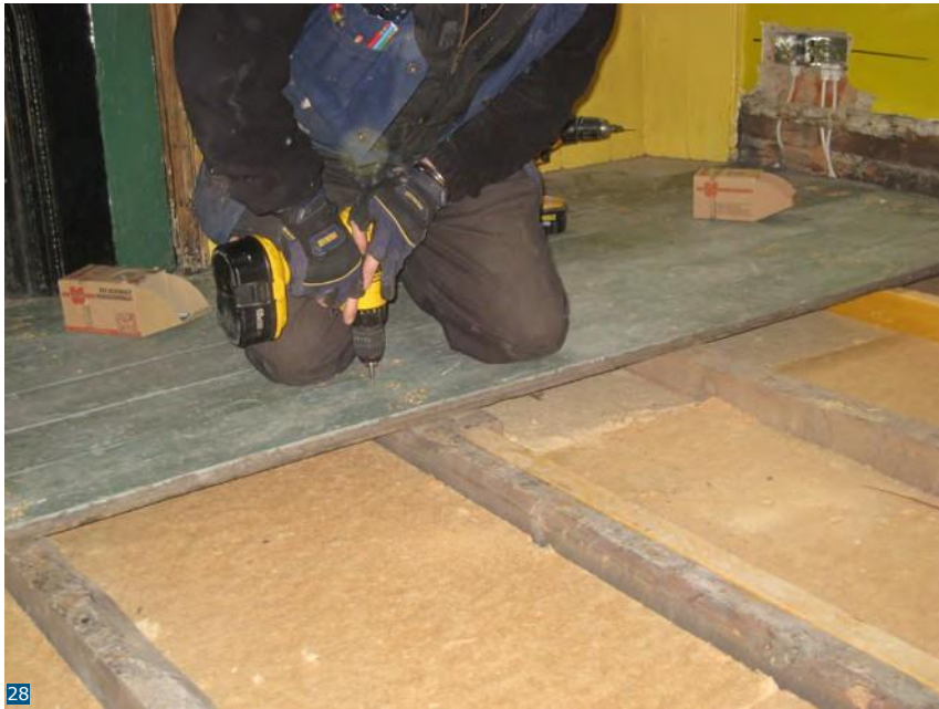
Εικόνα 28: Μεταφορά ενός ξύλινου δαπέδου μόλις τοποθετηθεί η μόνωση.
