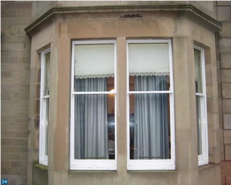
Εικόνα 34: Τα παραδοσιακά ρολά ρολά μπορούν να βοηθήσουν στη μείωση της απώλειας θερμότητας μέσω ενός παραθύρου.
