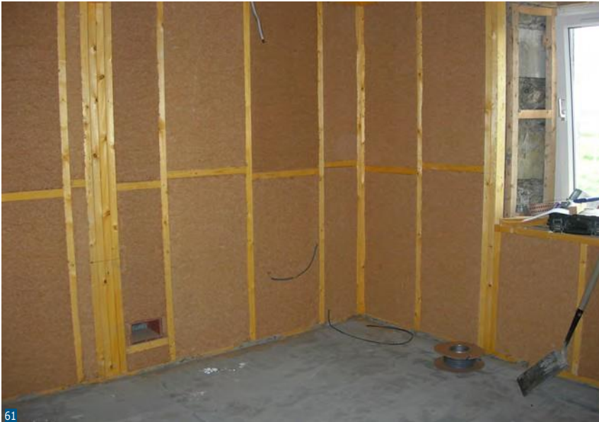
Εικόνα 61: Μόνωση ινοσανίδας από ξύλο που εφαρμόζεται μέσα σε πλαίσιο. Σε αυτό το παράδειγμα επιτεύχθηκε τιμή U 0,19.
