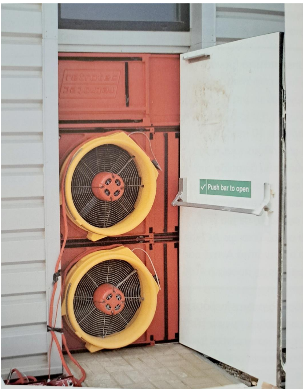
Εικόνα 9.1. : Δοκιμή μέτρησης αεροστεγανότητας
