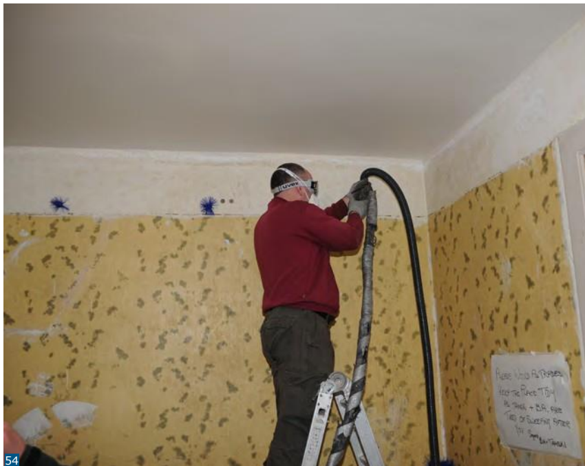
Εικόνα 54: Φύσημα ινών κυτταρίνης πίσω από πηγάκι και γύψο
