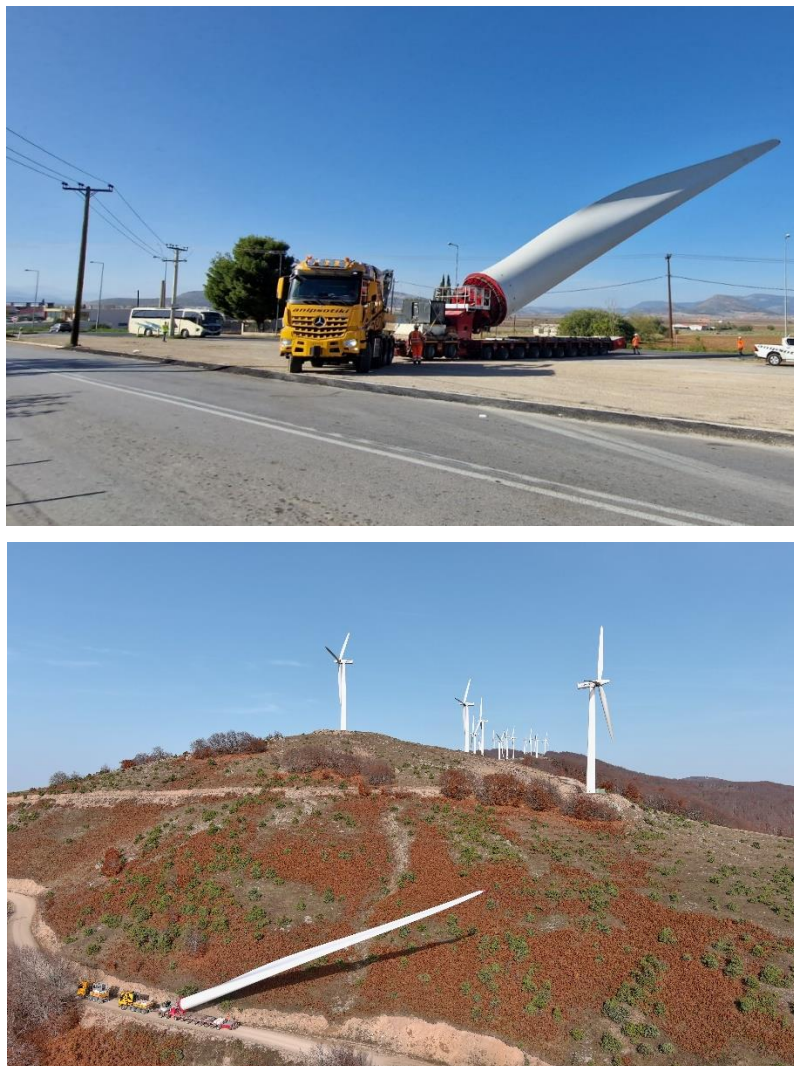
Εικόνα 2: Μεταφορά πτερυγίων με σύστημα ανύψωσης (blade lifter)
