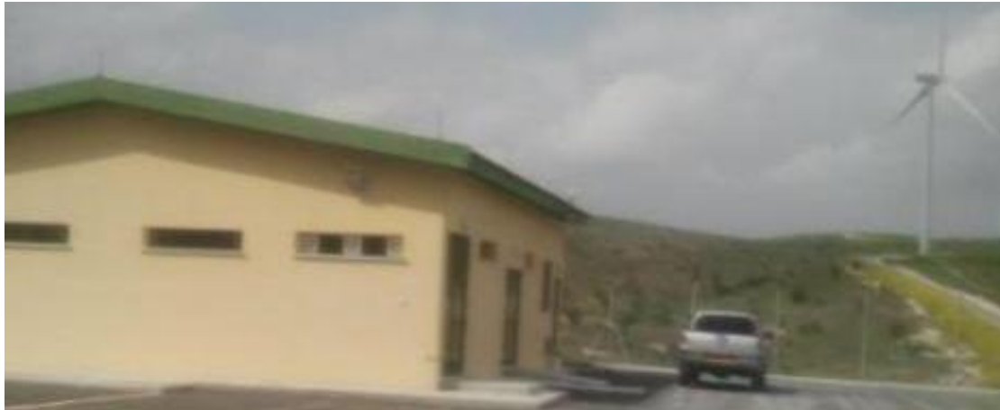
Εικόνα 5: Τυπική πρόσοψη κτιρίου ελέγχου Α/Π
