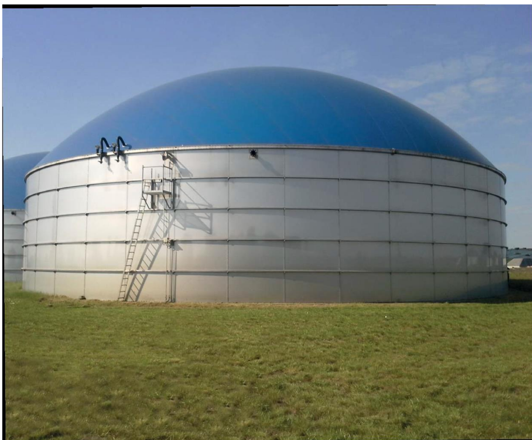
Εικόνα: Χωνευτήρες κατασκευής εταιρείας Τετώρος
