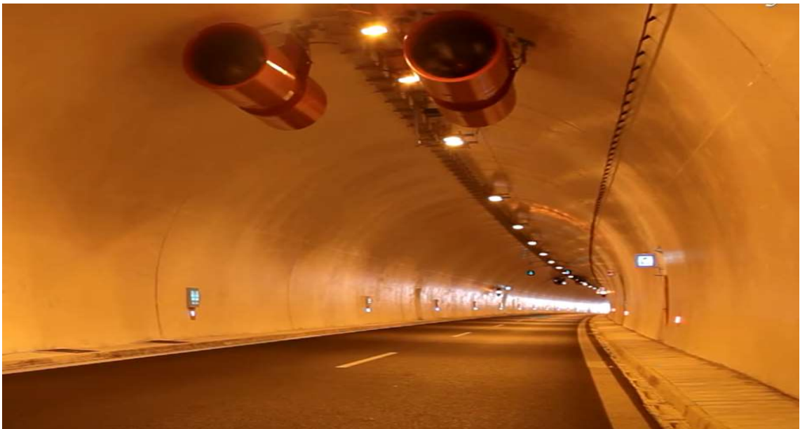
Εικόνα 53. Στυλίδα, Σήραγγα T7D
