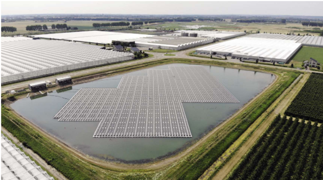
Εικόνα 33. Οι ινδικές δεξαμενές θα μπορούσαν να φιλοξενήσουν 280 GW πλωτή ηλιακή ενέργεια, σύμφωνα με μελέτη του Ινστιτούτου Ενέργειας και Πόρων.
