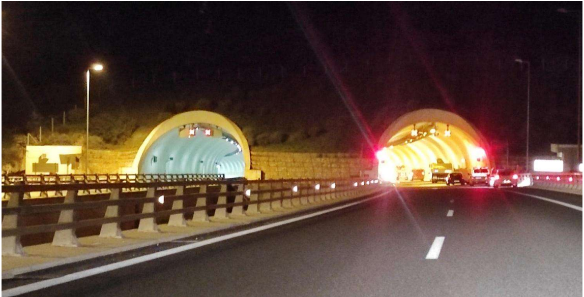
Εικόνα 52. Στυλίδα, Σήραγγα T3D και Σήραγγα T3A
