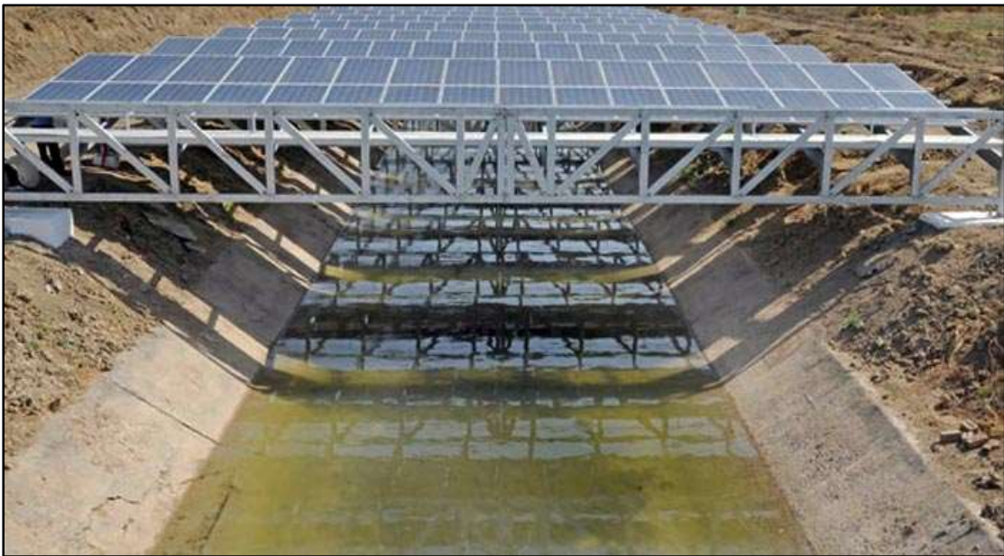
Εικόνα 60. Εγκατάσταση ηλιακών συλλεκτών τα κανάλια άρδευσης. 83
