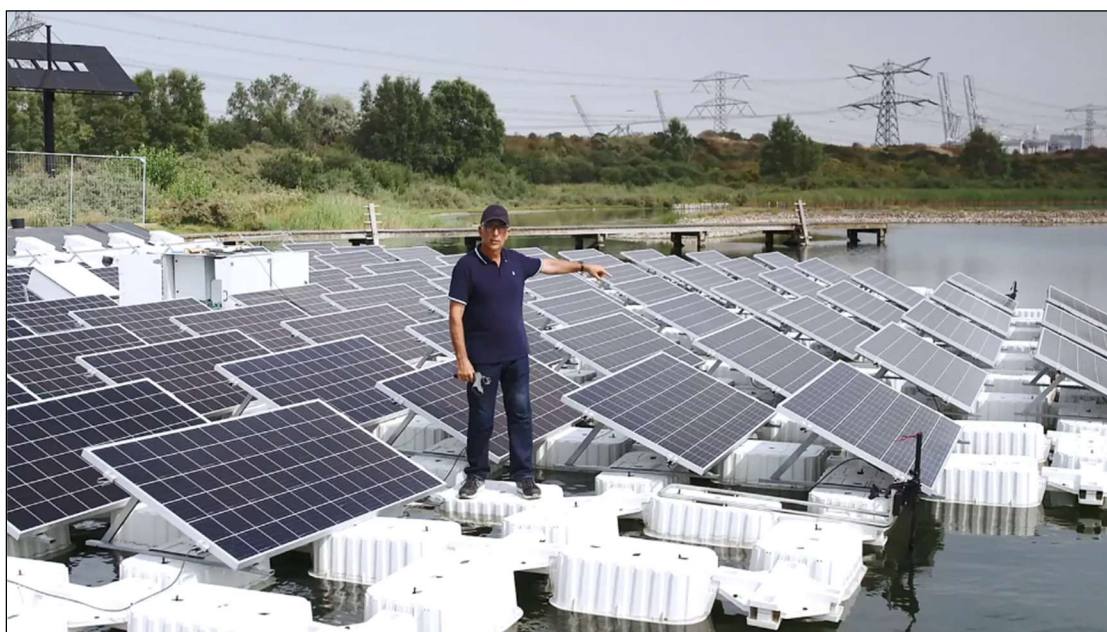
Εικόνα 40. Η Proteus είναι μια από τις πρώτες εγκαταστάσεις που συνδύασε τους πλωτούς ηλιακούς συλλέκτες με την τεχνολογία Sun-tracking
