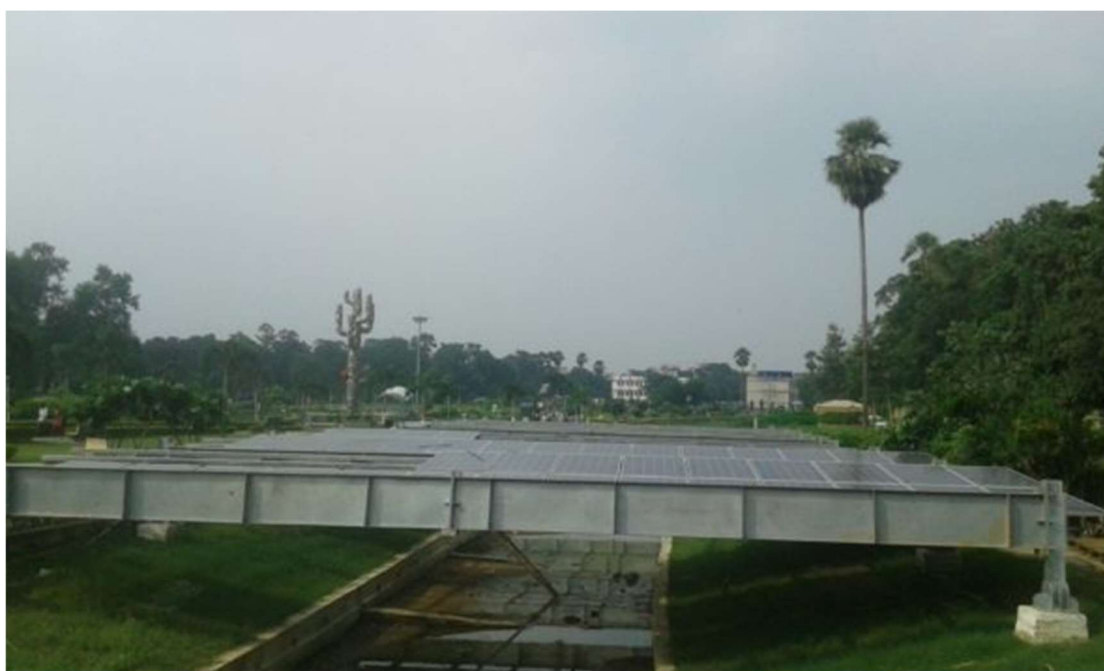
Εικόνα 32. Ηλιακό έργο στην κορυφή του καναλιού στο Μπιχάρ
