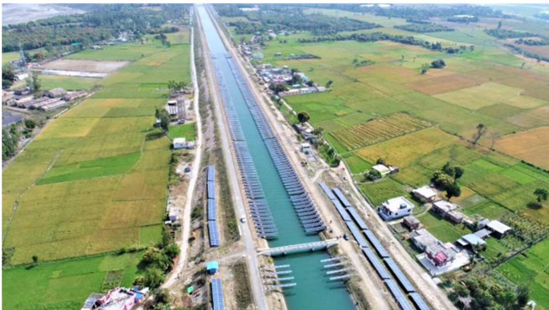
Εικόνα 31. Ανάρτηση με σχοινί από χάλυβα υψηλής αντοχής για ηλιακούς συλλέκτες σε κανάλια μεγάλου πλάτους.
