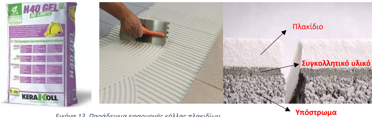
Εικόνα 13. Παράδειγμα εφαρμογής κόλλας πλακιδίων
