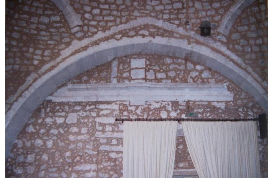
Εικόνα 5.1.3 – 5.1.4 Τμήμα του βόρειου τοίχου του τζαμιού. Ο τοίχος του βάθους με τη λίθινη κορνίζα ανήκει στο ναό της Παναγίας, ενώ το τόξο κατασκευάστηκε μετά τη μετατροπή του σε τζαμί.
