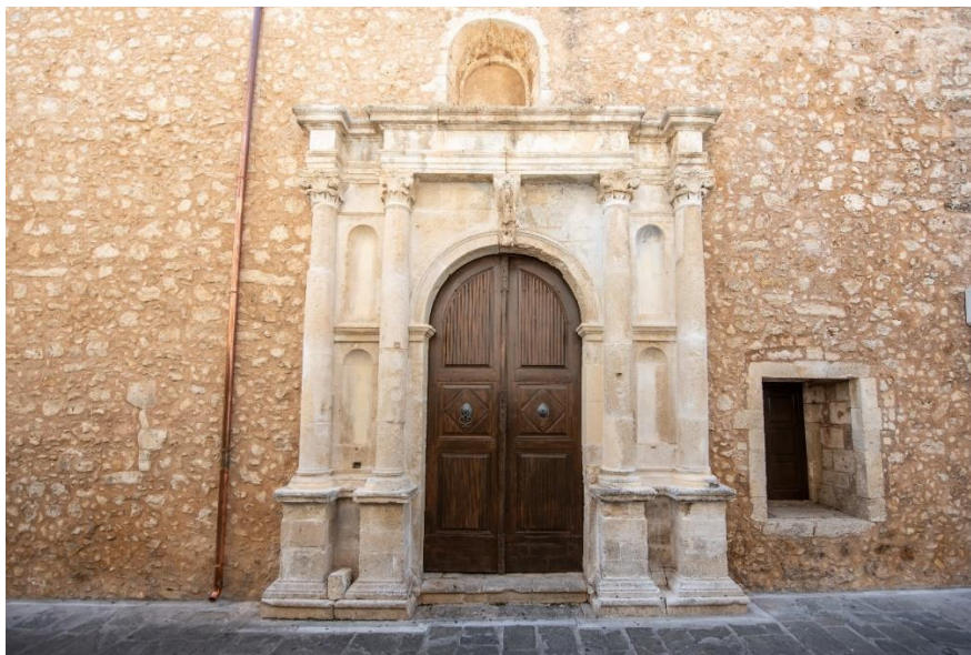
Εικόνα 5.1.5 Η κύρια είσοδος του Καθολικού της Μονής των Αυγουστινιανών μοναχών, βασισμένη σε σχέδιο του Ιταλού αρχιτέκτονα Sebastiano Serlio (16ος αιώνας)
