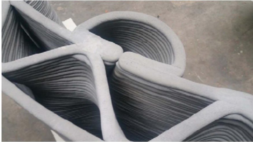
Εικόνα 6.1: Διάκριση στρωμάτων σε δομή σκυροδέματος, κατασκευασμένη με τρισδιάστατη εκτύπωση (Ngo, et al., 2018).
