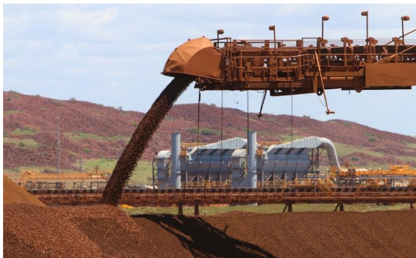
Εικόνα 5.4: Το τερματικό σιδηρομεταλλεύματος στο Cape Lambert
